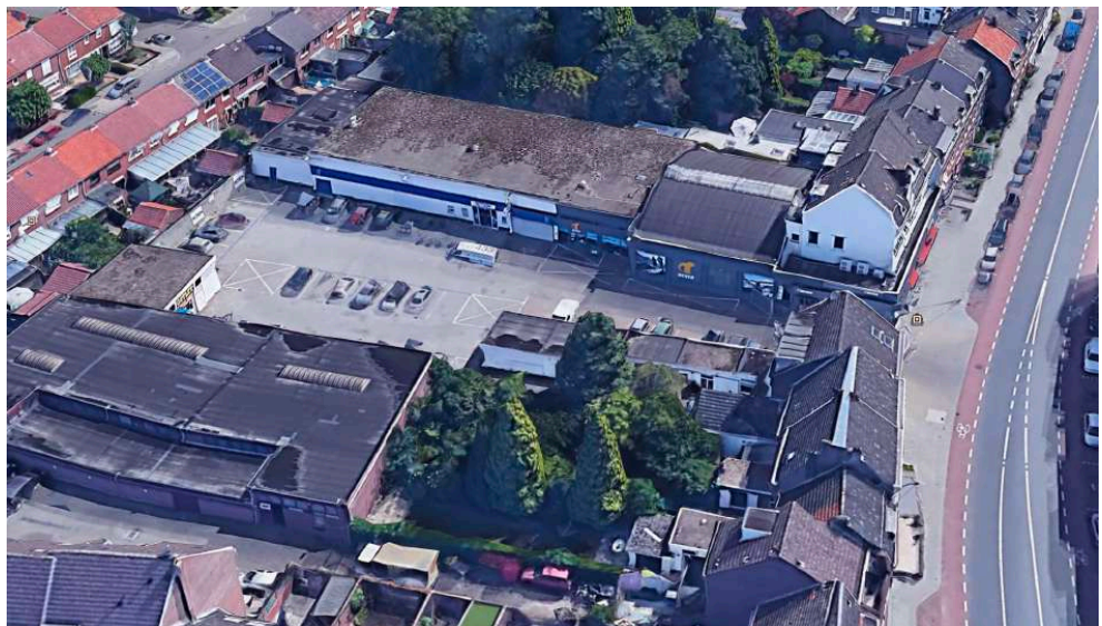
55 – luchtfoto locatie Scharnerweg 66-68, oostzijde gericht
