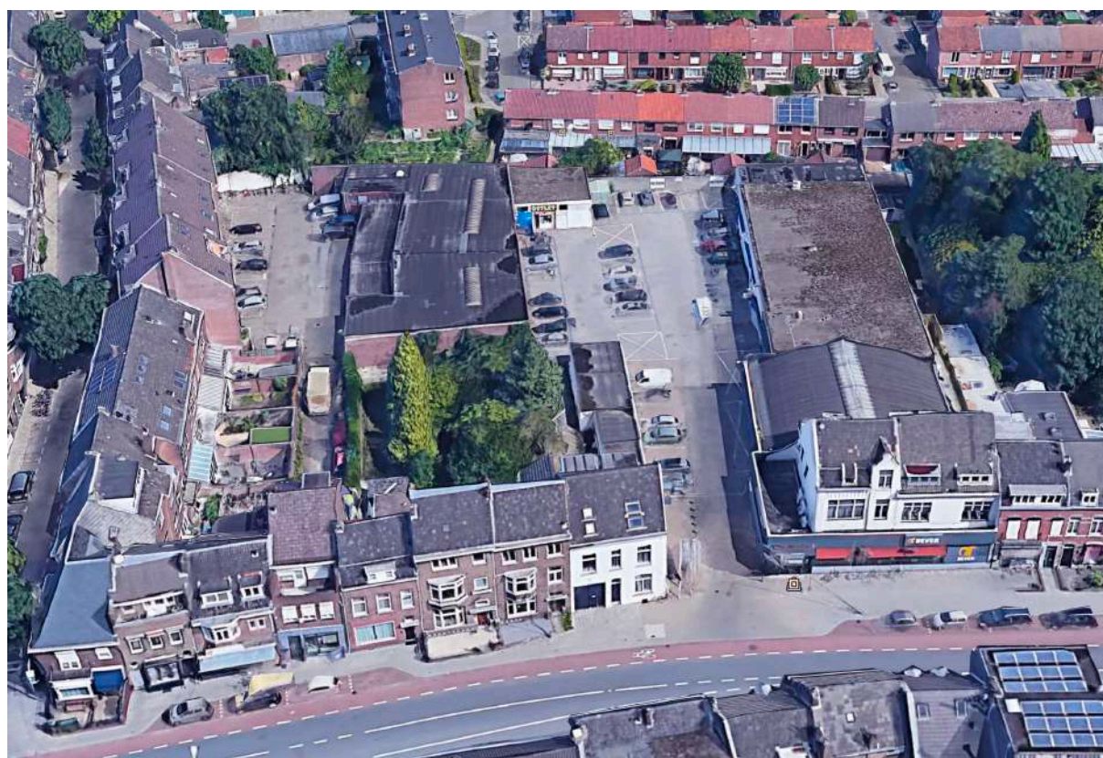
1 - luchtfoto locatie Scharnerweg 66-68, noordzijde gericht
