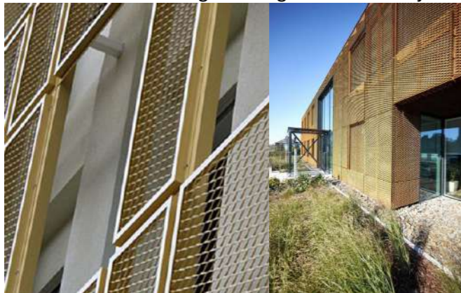
De strekmetalen vliesgevels zorgen voor afleesbaarheid van de kleinschalige woningen aan de hofzijde.
