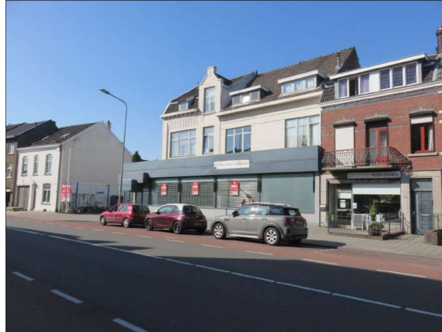
7 - Overzicht front locatie Scharnerweg 66-68
