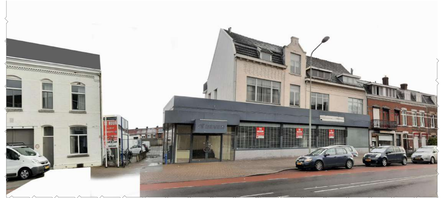
Foto Scharnerweg - bestaande toestand.
