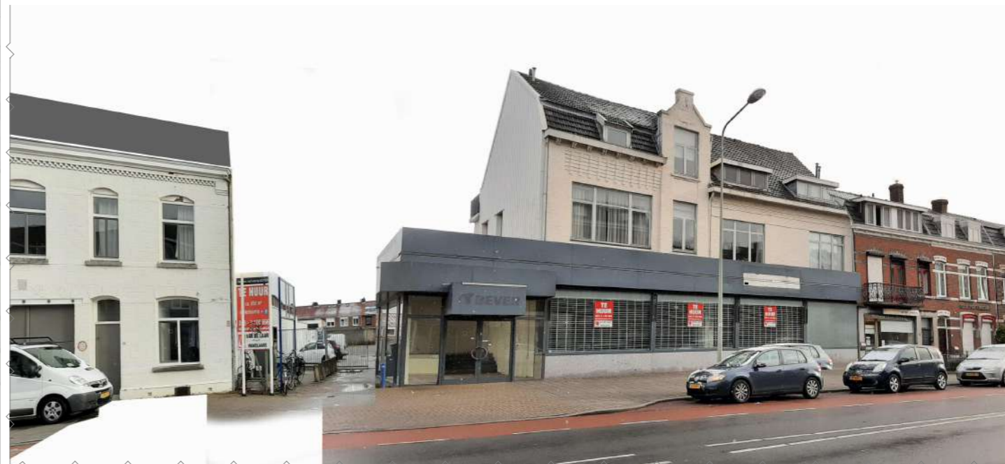
Foto Scharnerweg - bestaande toestand.
